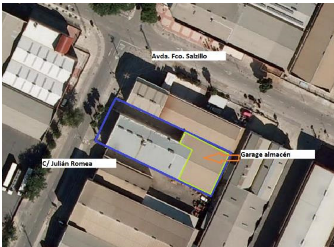
Imagen 3. Emplazamiento de la instalación en nave industrial anexa a otras naves industriales.
