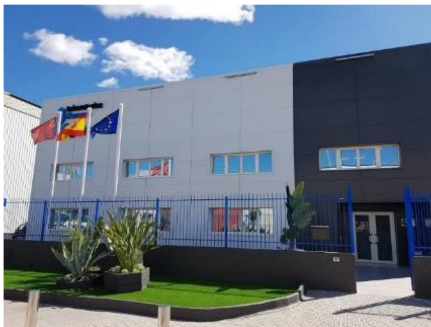
Imagen 4. Fachada de la instalación
