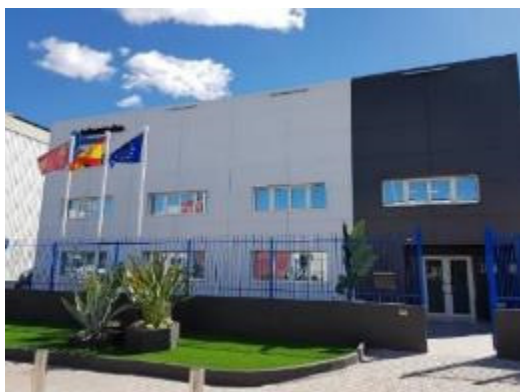
Fachada de la instalación
